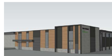
Usine de traitement des eaux usées
